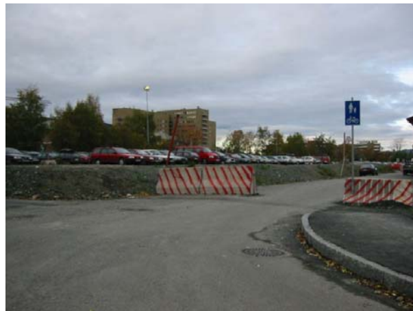
Anleggsarbeidene rundt St. Olavs Hospital skaper problemer for parkeringen
